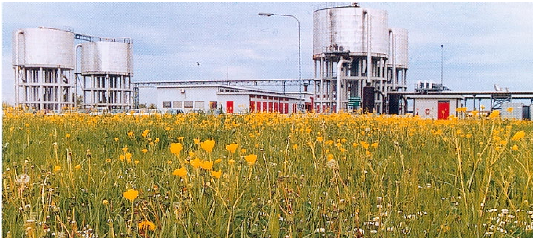
La centrale di teleriscaldamento di Ferrara
